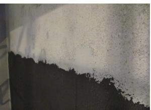
Die gespachtelten Flächen werden mit einem Haftvermittler für PU/Polyurea beschichtet. Beschichten der Flächen mit Polyurea. Dieses Material ist in chemischer und mechanischer Beständigkeit für diesen speziellen Anforderungsfall abgestimmt.
