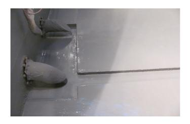
Nach dem Abbau der Beckenrüstung wird der Boden separat beschichet. Dabei wird in die Wandflächen überlappend eingearbeitet.
