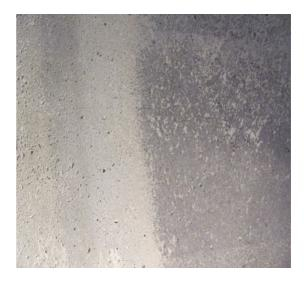
Die gereinigten Flächen werden gegen Bauwerksfeuchtigkeit abgesperrt und die restlichen losen Bereiche der Betonfläche verfestigt. Punktuelles verspachteln von Löchern, Lunkern und Rissen mit einem speziellen Betonspachtel.
